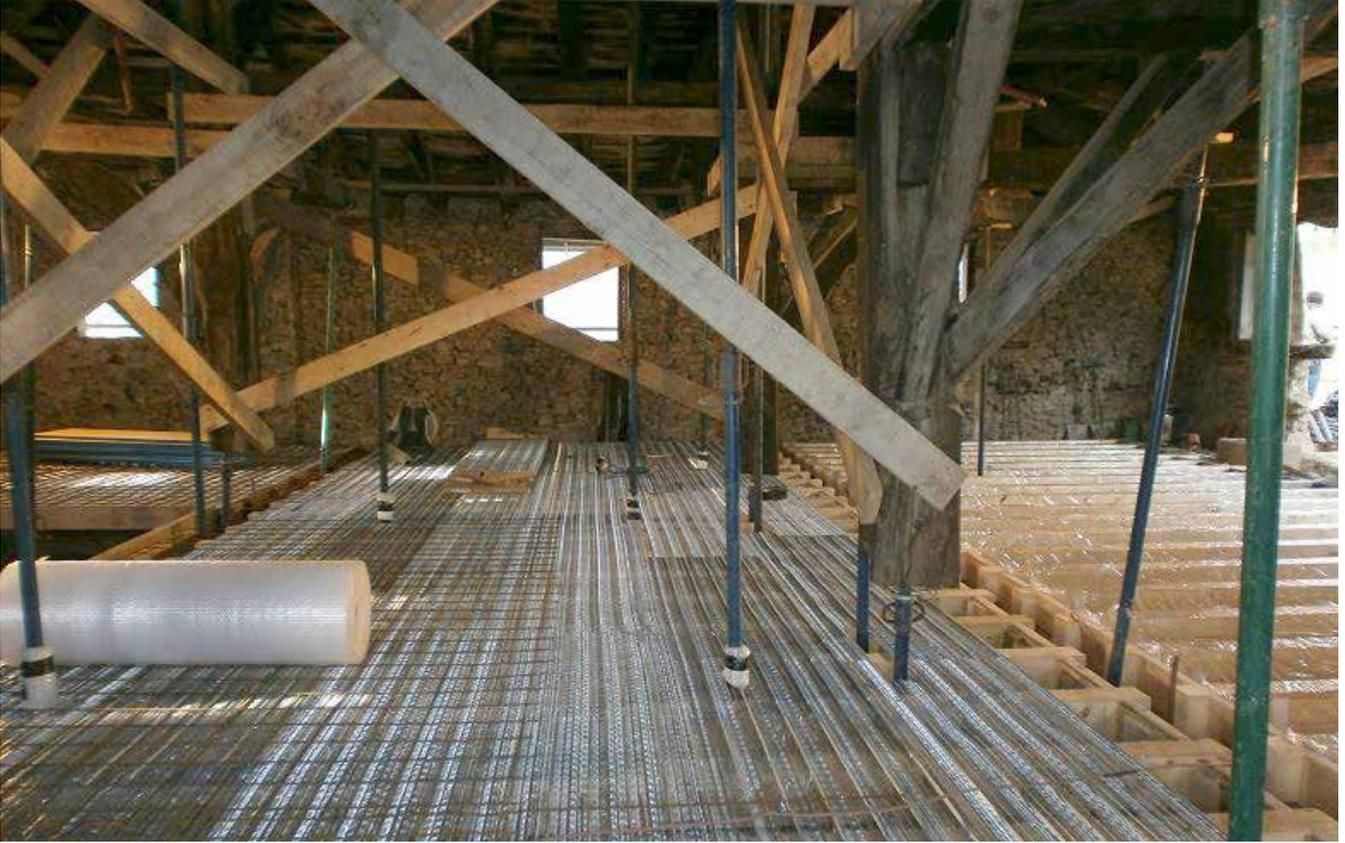
Construcción del forjado colaborante de hormigón - madera de planta bajocubierta.
