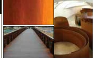
Para canalizar el agua se emplean placas de acero cortén, que podrán coger la forma idónea para cada situación. Su oxidación irá acorde con el proceso natural del agua.
